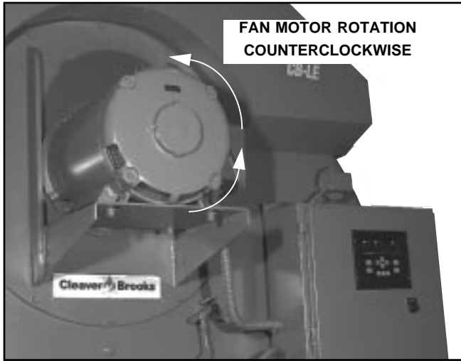
Figure: 5-1 Fan Motor CB-LE
